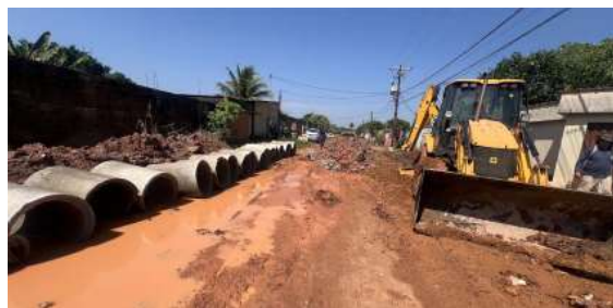
Serviços realizados entre setembro e outubro buscam melhorar o escoamento da água da chuva e reduzir os riscos de alagamentos.
