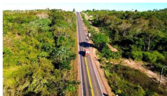
Rodovia permitirá desviar parte do transporte de cargas das vias urbanas, trazendo mais fluidez e segurança para motoristas.
