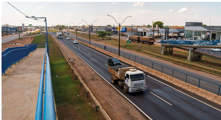
Trabalhos incluem recuperação do pavimento, microrrevestimento, sinalização e drenagem em diferentes trechos da rodovia.
