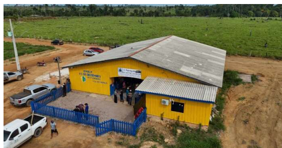
Unidade 03 de Dezembro foi construída pela própria comunidade e recebeu adequações da Prefeitura para iniciar o atendimento aos estudantes.
