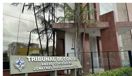
TCE-RO aponta possíveis falhas na concorrência e suspende licitação de R$ 3,7 milhões para manutenção de aparelhos de ar-condicionado nas escolas de Seringueiras.
