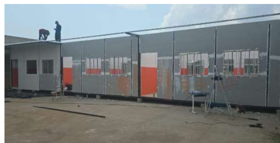
Estruturas serão instaladas em três unidades da rede e devem atender cerca de 400 estudantes; entrega está prevista para setembro.
