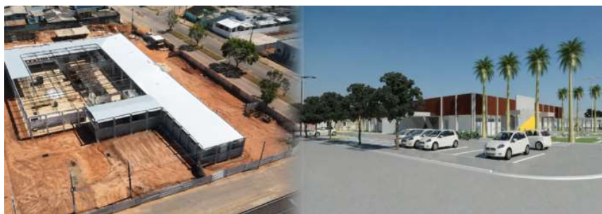
Obra recebe investimento superior a R$ 7 milhões e contará com estrutura moderna, segura, acessível e confortável para moradores e visitantes.
