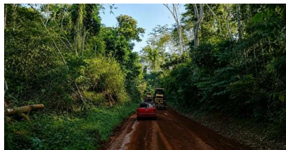
Os trabalhos incluem a recuperação de pontos críticos, patrolamento e adequações em trechos que apresentavam dificuldades de acesso.
