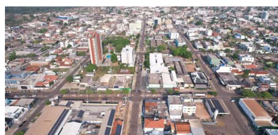
Município cobra na Justiça a execução de obras pendentes há mais de 15 anos e estima investimento superior a R$ 11 milhões para concluir a infraestrutura do loteamento.
