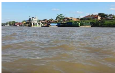
Obra de R$ 421 milhões deve fortalecer comércio internacional e impulsionar desenvolvimento de Guajará-Mirim.
