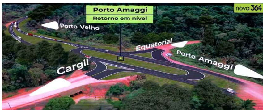
Concessionária busca acordos para reduzir impactos das obras na BR-364.
