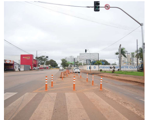
Nova ferramenta já começou a ser utilizada em pontos da Estrada da Penal.
