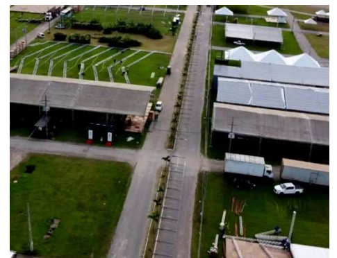
As ruas do parque receberam revestimento com pedra brita, garantindo uma estrutura adequada para suportar o intenso fluxo de visitantes.
