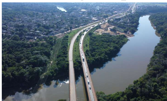
Obras somam mais de R$ 500 milhões e incluem acesso ao Porto Novo e recuperação de rodovias.
