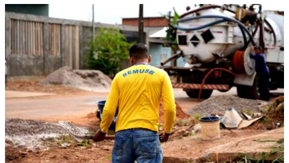
Quase uma tonelada de cimento está sendo utilizada.
