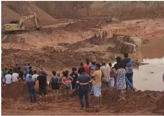
Barranco cedeu e trabalhador ficou soterrado dentro da escavadeira. Outras três pessoas foram resgatadas com ferimentos e estão estáveis.
