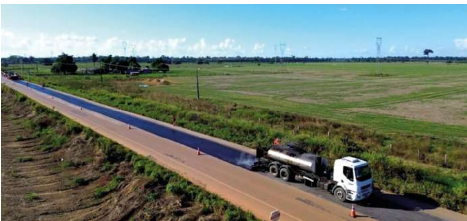
Volume de aportes é o maior da história da rodovia em Rondônia e foca na reconstrução do pavimento no corredor portuário do Rio Madeira.
