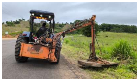
A RO 470 recebe manutenção no asfalto e roçada mecanizada.
