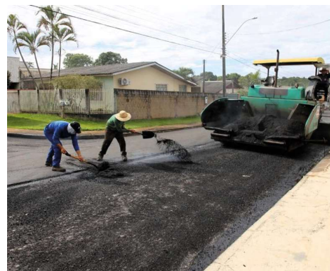
Investimento próprio reforça manutenção e expansão da malha viária urbana.
