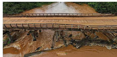
A iniciativa visa substituir a antiga ponte de madeira que serve como principal via de ligação para a região rural.
