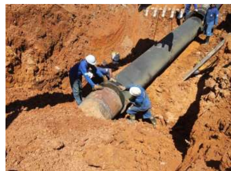
Funcionários da Caerd trabalham na recuperação de uma adutora no bairro da Zona Leste de Porto Velho.
