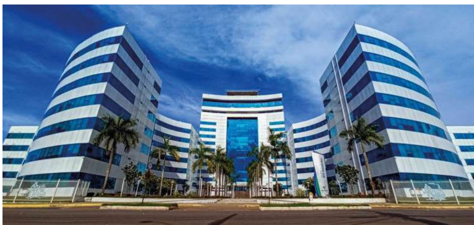
STF reforça obrigatoriedade do regime constitucional de precatórios e suspende pagamentos diretos da Caerd.
