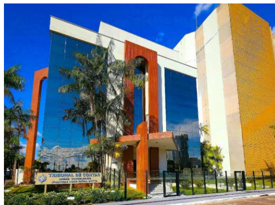
Determinação do TCE-RO reitera exigências dos itens V e VI do Acórdão APL-TC 00205/24 e prevê aplicação de multa em caso de novo descumprimento.
