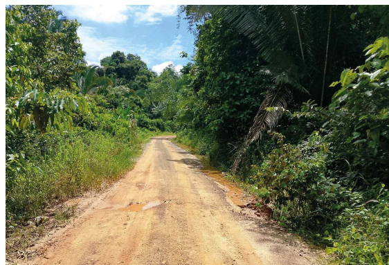
Serviços devem começar na primeira quinzena de fevereiro para melhorar a trafegabilidade.
