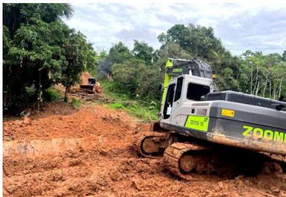
Obra de drenagem melhora escoamento da água da chuva e facilita o tráfego na região.
