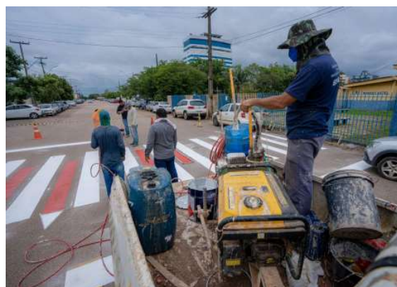
Intervenções também incluem manutenção do pavimento nos trechos onde a sinalização é aplicada.
