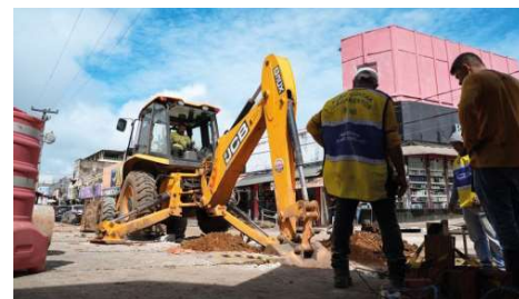
Os serviços vão garantir mais fluidez no escoamento da água e mais segurança para quem trabalha e circula pela região.
