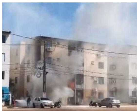
Incêndio atinge bloco residencial e mobiliza Corpo de Bombeiros.
