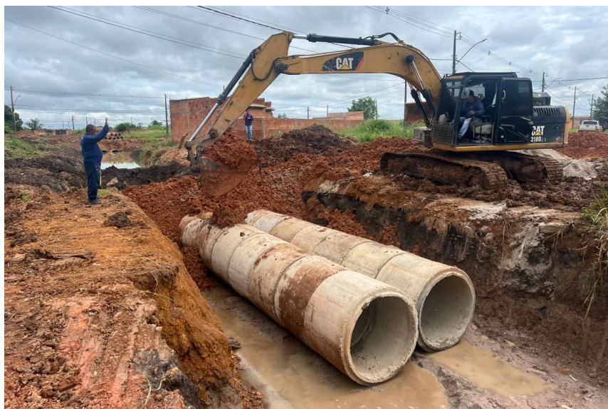
Intervenções estruturantes melhoram o escoamento das águas pluviais e reforçam a prevenção a transtornos causados pelas chuvas em áreas mais vulneráveis da capital.
