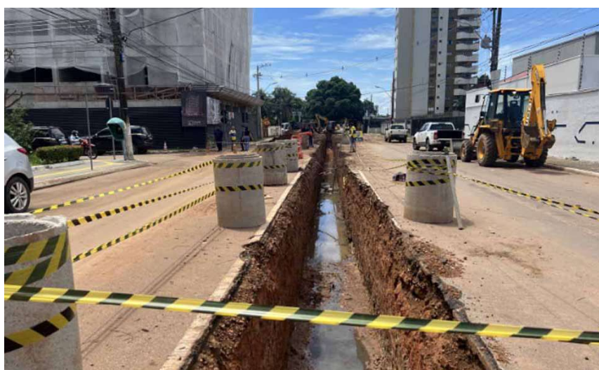
Manilhas de 60 centímetros foram substituídas por novas de 80 centímetros, ampliando a capacidade de vazão da água e garantindo maior eficiência.
