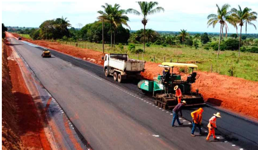
Na etapa inicial, foram concluídos 800 metros de pavimentação asfáltica. Ao todo, está previsto a execução de 8 quilômetros de asfalto.
