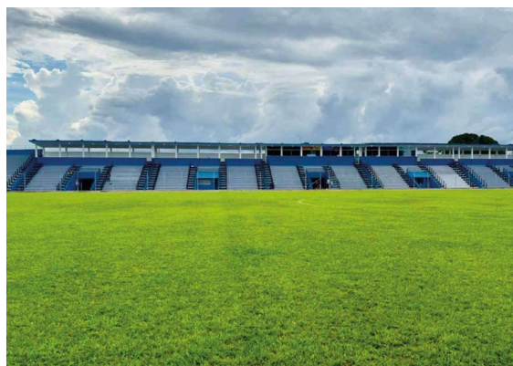
As intervenções atendem às normas técnicas e de segurança estabelecidas pelo Corpo de Bombeiros Militar e pela Federação de Futebol do Estado de Rondônia (FFER).
