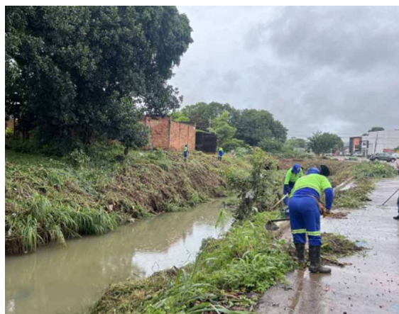
Serviço teve como objetivo principal melhorar o escoamento das águas pluviais e reduzir os riscos de alagamentos.
