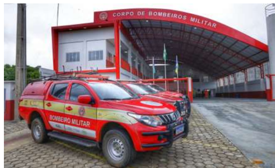
A obra reforça os investimentos estaduais na ampliação da segurança pública e na melhoria da capacidade de atendimento às ocorrências de emergência no interior.
