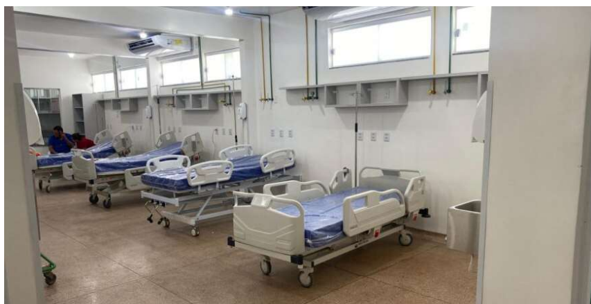
A Sala Vermelha passou por reformulação, com substituição de pisos, revestimentos, portas, pias, redes de água e esgoto, circuitos elétricos, redes de dados, além de nova cobertura e climatização.
