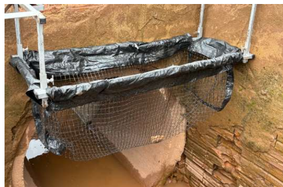
Cidade intensifica ações de drenagem com instalação de ecobueiros em pontos críticos para prevenir alagamentos.
