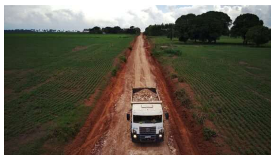
RO 135, sentido Novo Horizonte recebe manutenção executada pelo o Departamento Estadual de Estradas de Rodagem e Transportes (DER-RO).
