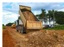
22 km de manutenção está sendo executado na RO 135.
