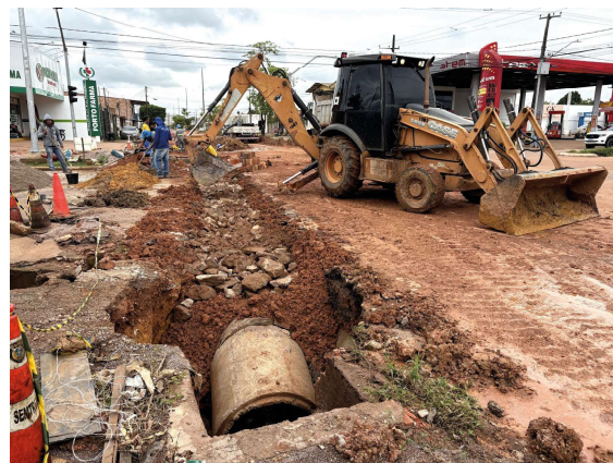
Prefeitura segue atuando para reduzir alagamentos e ampliar a eficiência do sistema de drenagem; Ajustes técnicos reorganizam o percurso das águas e melhoram o escoamento na região.
