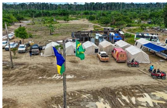
Durante os trabalhos, as equipes realizaram incursões e demoliram todas as estruturas irregulares.
