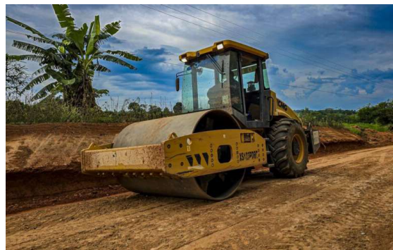
DER executa obra de manutenção na RO 010 sentido Nova Brasilândia.
