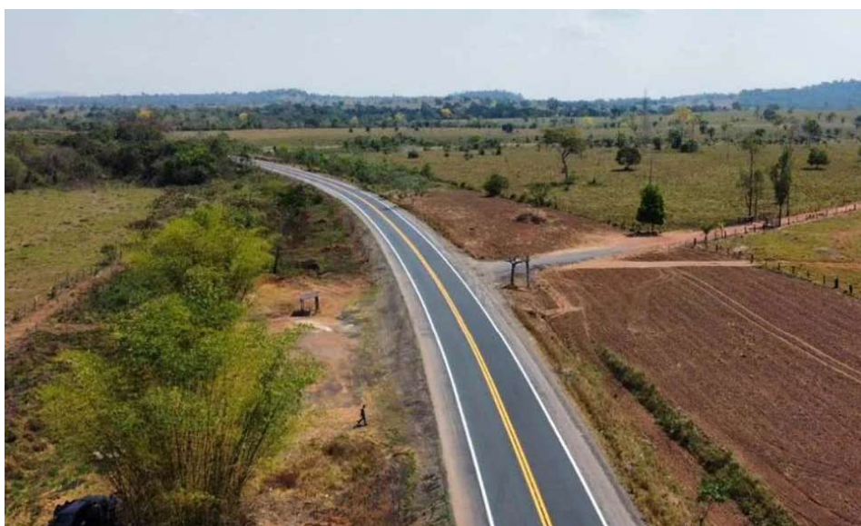
Governo amplia pavimentação e moderniza estradas em todas as regiões do estado.
