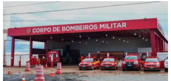
Sede do Corpo de Bombeiros de Pimenta Bueno.
