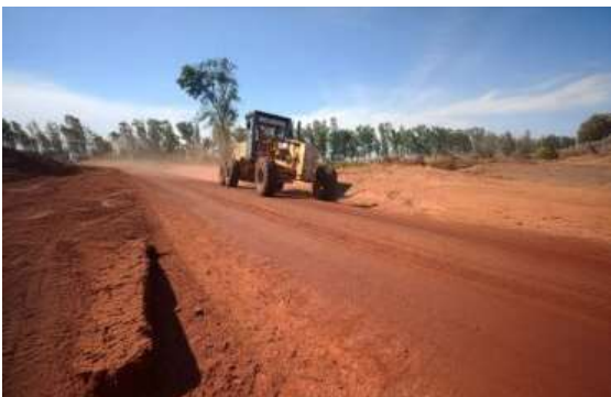
Obras na RO-493, em Pimenta Bueno.
