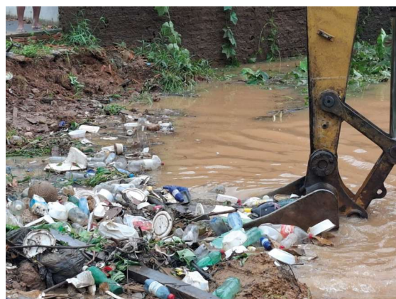
Intervenção no canal do Tancredo Neves reforça a prevenção de alagamentos.
