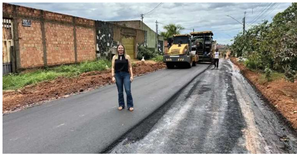
A vereadora esteve no local para acompanhar o início dos trabalhos e destacou a importância da intervenção.
