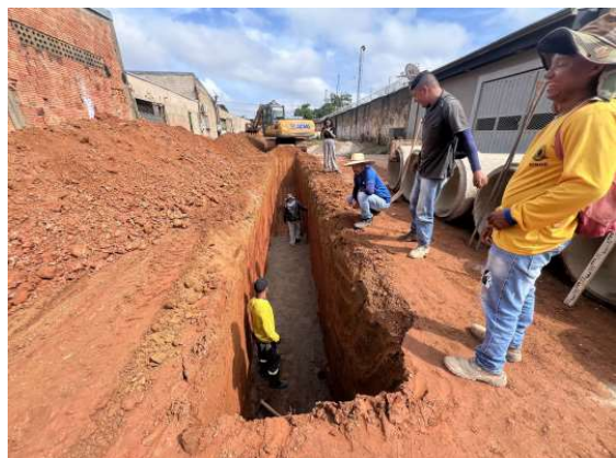
Serviços envolvem desde a escavação e preparação do solo até a colocação das manilhas.
