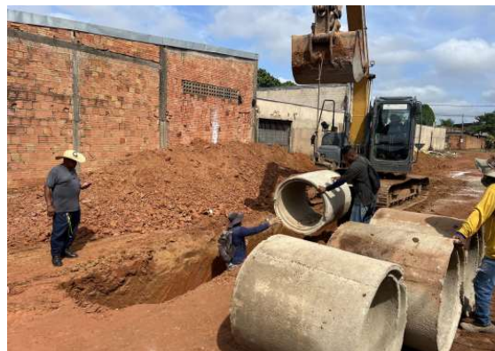
Obra contempla a instalação de 75 metros de manilhas de 80 centímetros.
