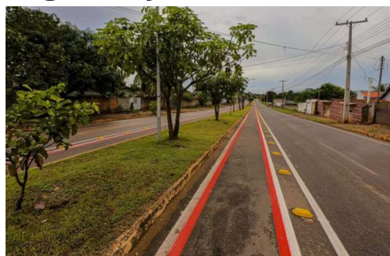
A via recebeu serviços de pintura, tachões e nova sinalização horizontal, garantindo mais segurança para quem utiliza a via diariamente.
