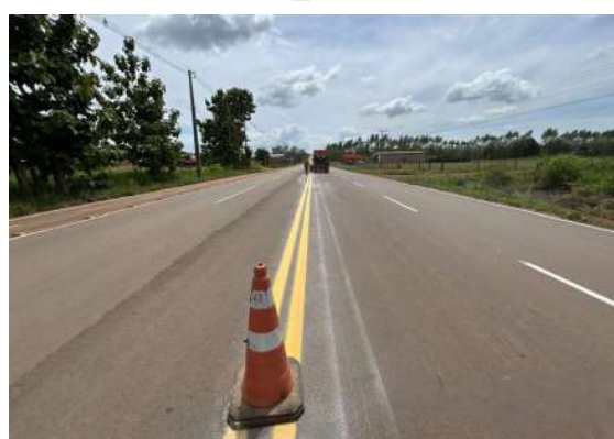
A ciclofaixa recebeu nova sinalização horizontal e vertical, correções estruturais e reforço no pavimento.
