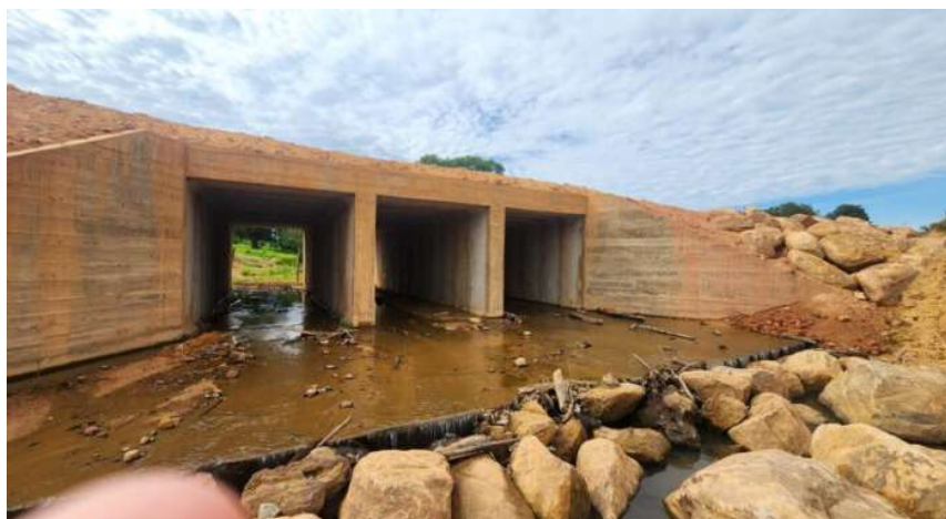
Com 9 metros de extensão e três vazões de 3 metros cada, a estrutura substitui a antiga passagem.
