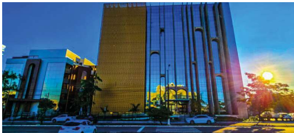
Fachada do prédio do TCE-RO, em Porto Velho.
