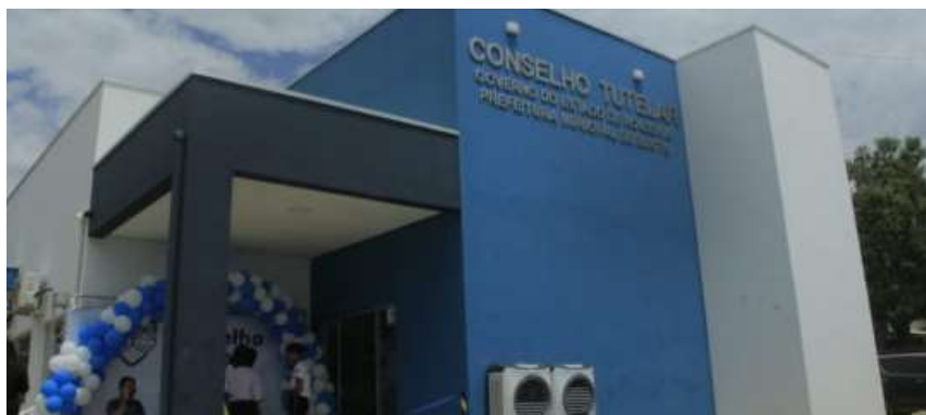
A etapa de Infraestrutura do programa Criança Protegida prevê a construção de Conselhos Tutelares nos municípios.
