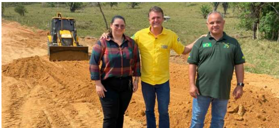
As melhorias estão sendo realizadas em pontos estratégicos, como na linha 05, região dos Três Coqueiros e Rio Grande.
