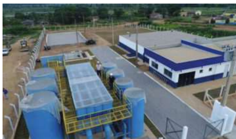
Estação de Tratamento de água em União Bandeirantes.
