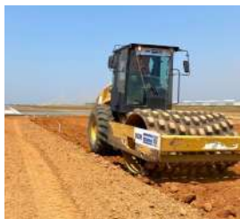
A obra vai proporcionar mais segurança nas operações de pouso e decolagem.
