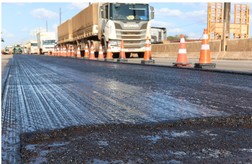
As principais frentes avançaram na correção de buracos, ondulações e falhas no pavimento. No total, foram mais de 3 mil toneladas de massa asfáltica, o equivalente a 250 caçambas de caminhão.
