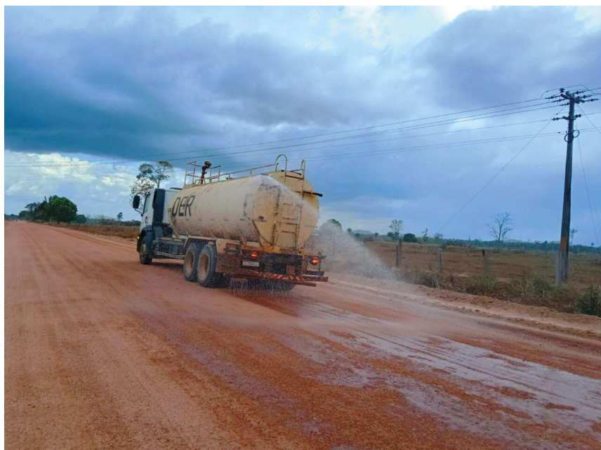
Com 30 quilômetros de extensão, a RO-459 liga o município de Alto Paraíso ao distrito de Bom Futuro.
