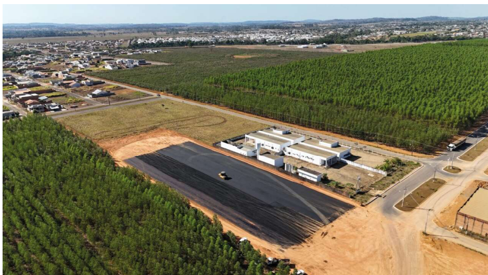
O terreno que fica no final da Avenida Tancredo Neves, foi nivelado, compactado e recebeu 680 toneladas de massa asfáltica.
